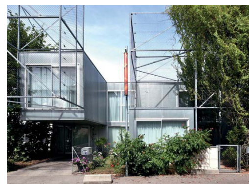
Begrønning af omdannet bebyggelse Cité Manifeste, Lacaton & Vassal Architectes
