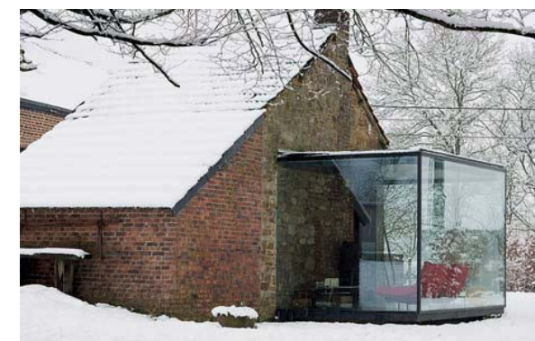
Renovering og mindre nye tilbygninger Maison Roly, AABE
