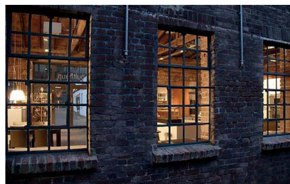
Renoveres og omdannes til boliger Lagerhalle 6, Andreas Lievenbrück
